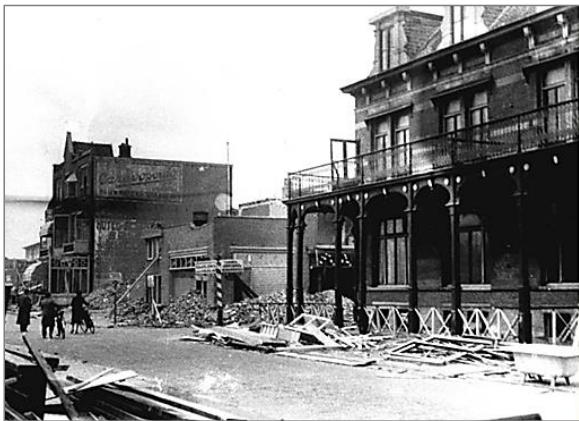
De sloop van de Mezgerstraat / hoek Zeestraat. Rechts de horlogerie van Trompetter en Pension Zendijk, op de hoek met de Zeestraat. Daarachter het begin van de vroegere Engelberstraat.
