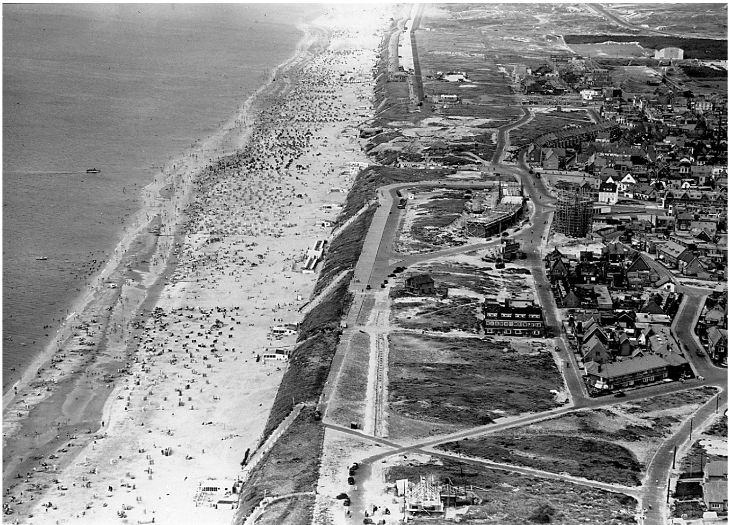
Panoramafoto van de wederopbouw van Zandvoort, 1950. Het huizenlint in de Engelbertsstraat is gereed. In aanbouw zijn de nieuwe watertoren en de Thorbeckestraat. Midden boven Restaurant Garni en Paviljoen Kiefer. Rechts naast Garni een roetsjbaan op de plek waar zich voorheen joodse winkels bevonden. Collectie GOZ.
